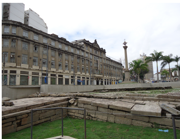
Estrutura do Cais do Valongo (1811), depois Cais da Imperatriz (1843) aterrada em 1911 e redescoberta com as obras da Zona Portuária em 2012. Foto Sheila Geraldo
