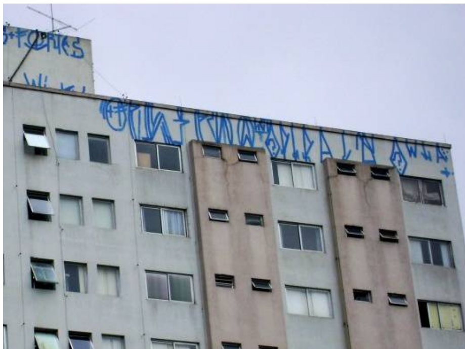
Edifício pichado, São Paulo Foto Edgar Fabiano [Wikimedia Commons]
